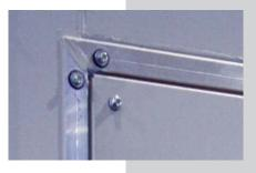
**Sheet metal door frame,** not thermal broken.
